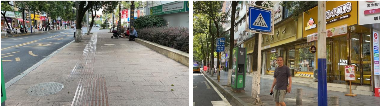
图2-53 西大街长兴东路段（左）和同心东路段（右）现状
